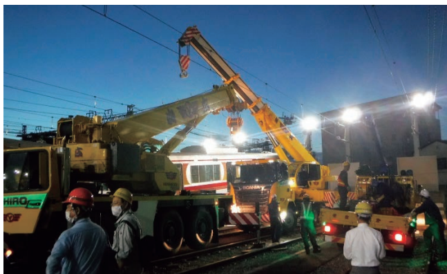
復旧作業の様子(事故当日)
