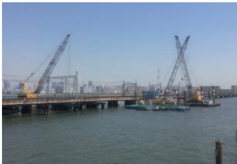
現在の工事の様子
