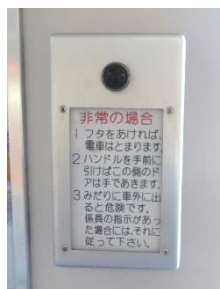
非常通報装置
