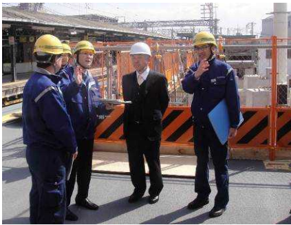
甲子園駅改良工事視察（社長）
