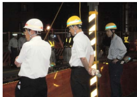
鳴尾連立工事視察（都市交通事業本部長）
