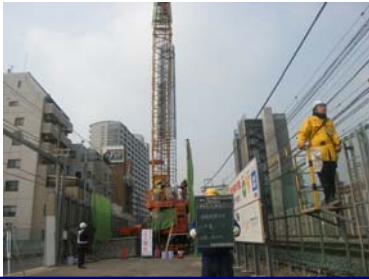
【高架橋工事現場(神戸市内)】
