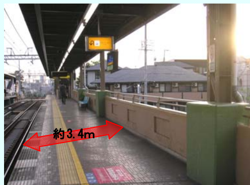
【プラットホーム拡幅前】
