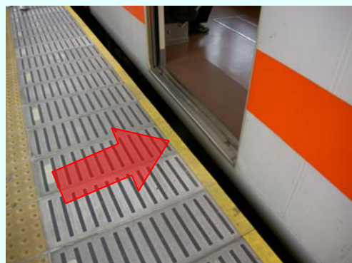
【櫛状ゴム 設置現場】
