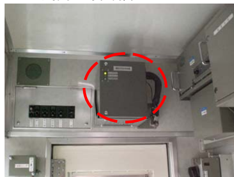
【運転状況記録装置】
