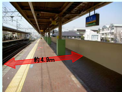
【プラットホーム拡幅後】
