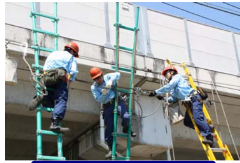
【電車線断線復旧訓練】
