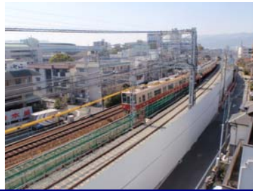
【仮線工事現場(西宮市内)】
