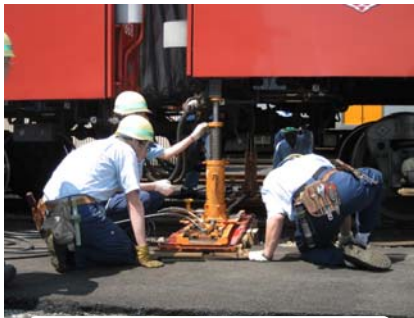
【脱線復旧訓練】
