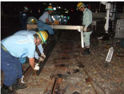
【接着絶縁レール更換実習】
