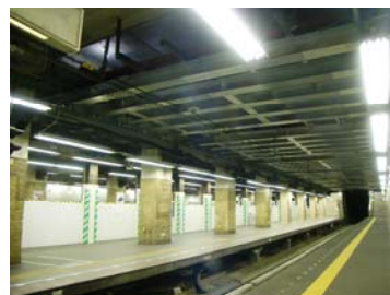
【コンコース中床版設置状況】
