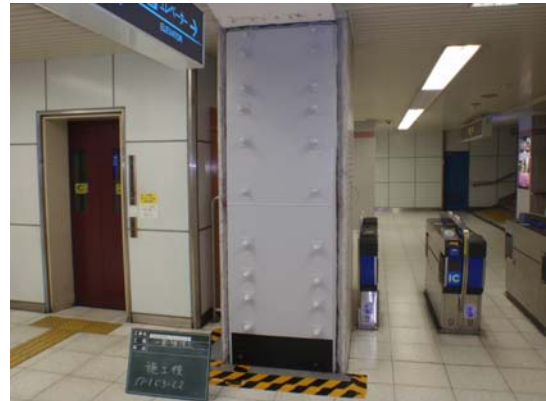
【一面せん断補強工法】
