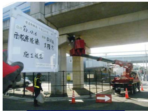
【近傍での詳細目視検査】
