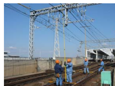
【交差装置点検】
