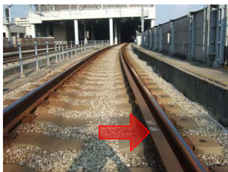
【脱線防止ガード 設置現場】
