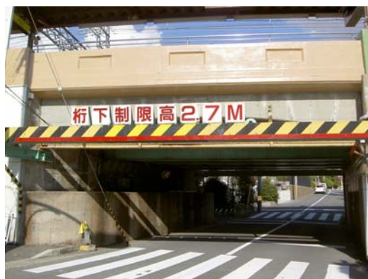
【橋桁防護工(桁)】
