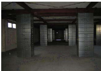
小型鋼製パネル工法
