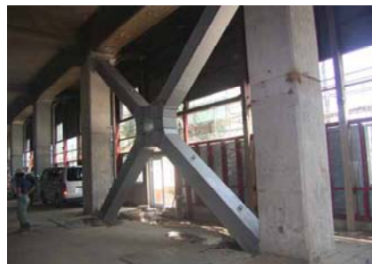
圧縮型鋼製ダンパーブレース工法
