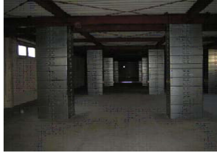
小型鋼製パネル工法
