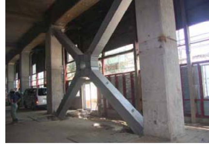
圧縮型鋼製ダンパーブレース工法
